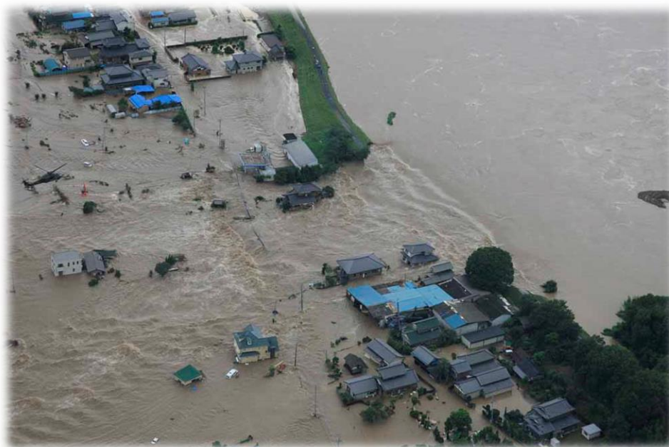
決壊現場(提供:国土交通省関東地方整備局)堤防
